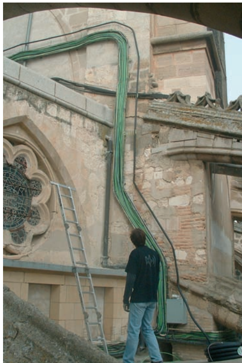
Se distribuyeron aproximadamente 5.000 metros de cable por tejados y exteriores
