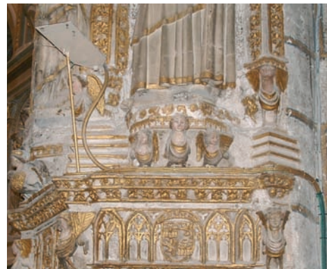
Para la “mimetización” del cableado que transcurre por retablos y altares se contó con la ayuda de un licenciado en bellas artes. Además, su fijación tuvo que ser extremadamente delicada
